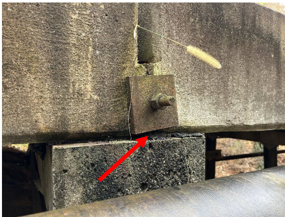
Photo 3. ACM Bent Cap Felt.
